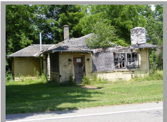
2300 Owego Rd., Town of Vestal
